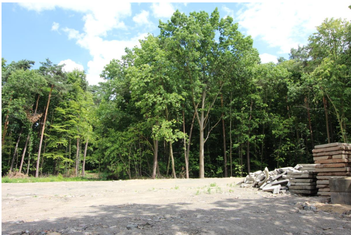
Fot. 1. Widok na działkę 434/15 w kierunku północno-wschodnim; widoczne elementy odpadów budowlanych – 4.07.2023 r.; godz. 14 08 .
