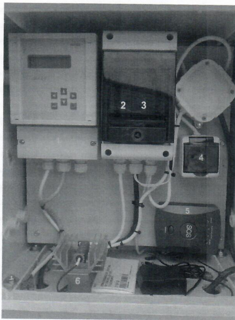
Zdj. nr 3 1. przetwornik pomiarowy – usm-01 2. termostat grzałki – rt-41 3. przełącznika zasilania – pzm-10 4. gniazdo 1-fazowe zasilania modułu gsm 5. bezprzewodowy moduł alarmowy gsm 6. - grzałka
